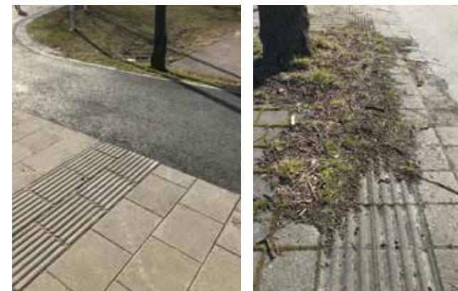
Fotot till vänster visar ett taktilt stråk som upphör på felaktigt sätt. Bilden till höger ett taktilt stråk där bristen på underhåll gjort att stråket inte fungerar som avsett.
