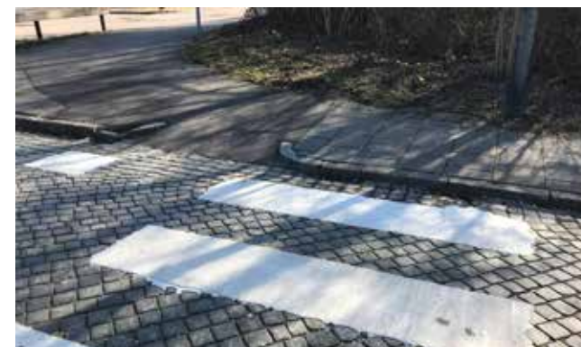
Övergångsställe där avfasad del saknas för den del som är reserverad för gående. Utformningen tvingar ut personer med rullstolar, rollatorer och barnvagnar i delen för cyklande.
