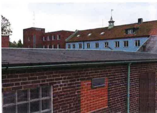
Exempel på takpapp, i detta fall på den östra flygelbyggnaden samt exempelbild på avvattningen i grönmålad plåt.
