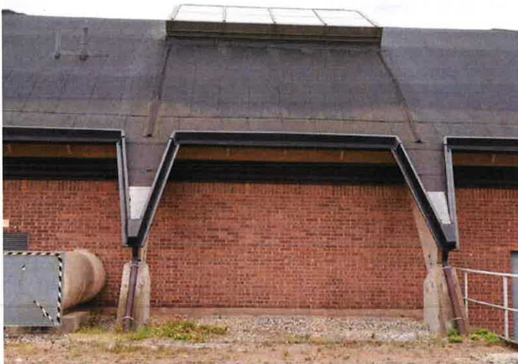
Sektion av tillbyggnadens rytmiskt placerade limträbalkar.
