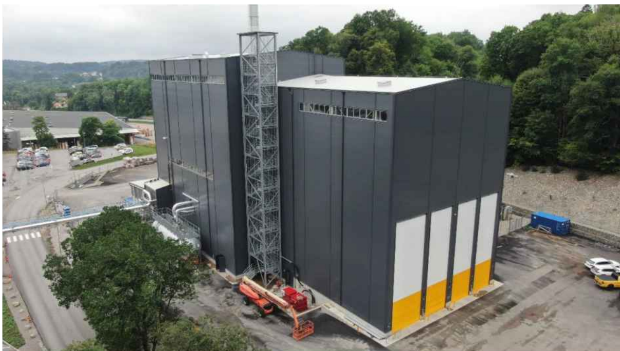
Figur 7.4. Flygbild över nybyggd förbränningsanläggning i Munkedal för återvunna bränslen som visar exempel på hur jalusiportar till tippfickan kan utformas. Pannan är dock dubbelt så stor som den ansökta baslastpannan vid Östervångsverket. Källa: Adven.
