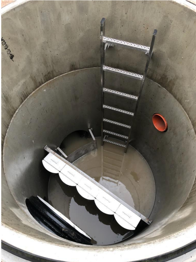
Figur 7. Exempel på filterkassett för dagvattenrening. Bilder hämtade från Flexicleans hemsida 2022-11-07.
