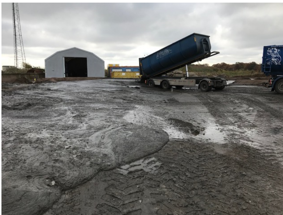
Nyttippade muddermassor från Gislöv som sedan bearbetats med grus för att kunna användas som täckning av deponi.
