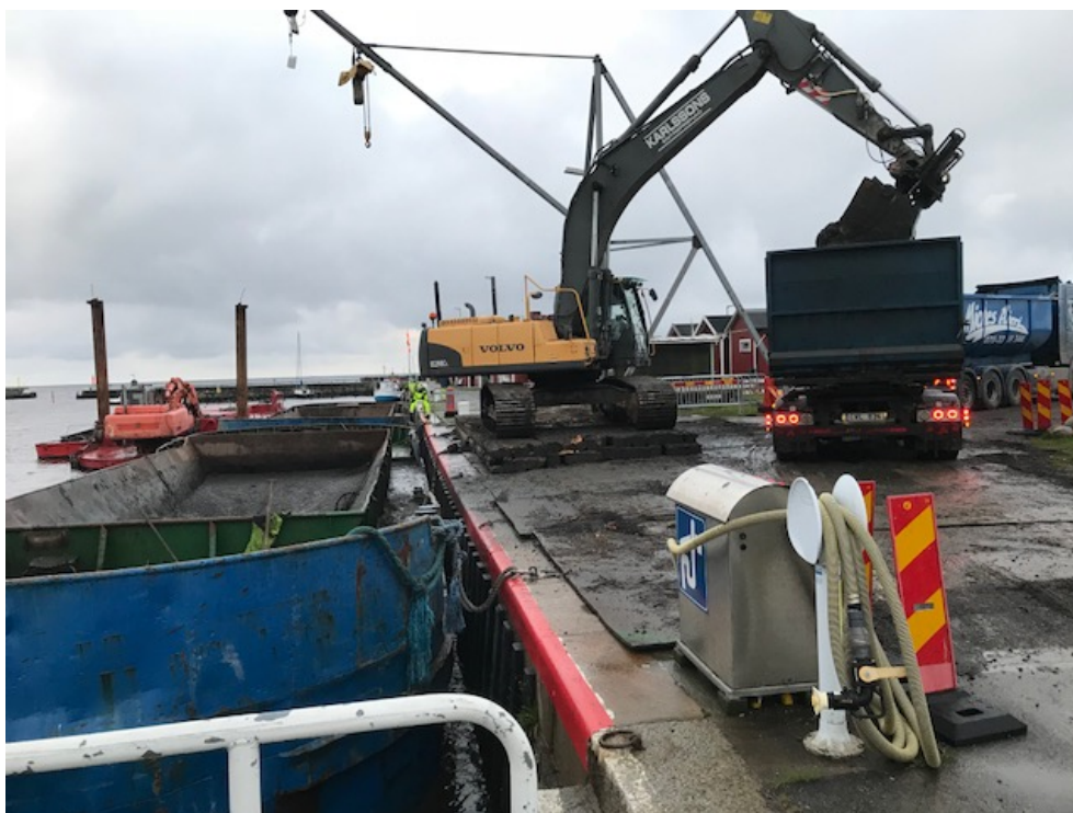
Lastning av muddermassor Gislövs hamn för transport till Svealas, Hedeskoga Ystad.
