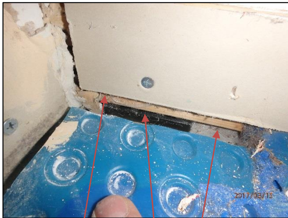
Foto 36, innerväggssyll, plastkilar, plastfolie
