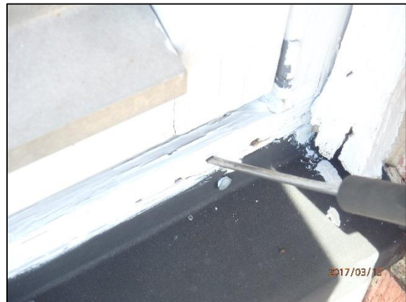
Foto 7, rötskador i nyare fönster mot söder
