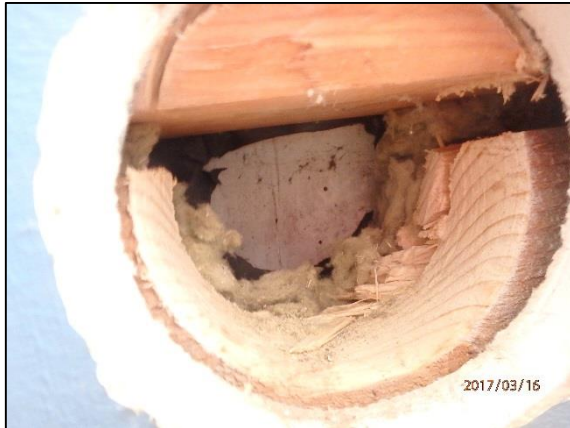
Foto 47, vindpapp mot missfärgad träpanel
