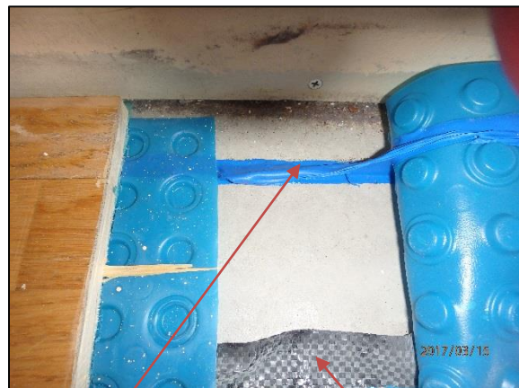
Foto 32, tätmassa mot avjämning, fiberduk
