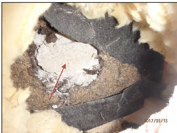
Foto 35, luftspalt helt fylld med bruk
