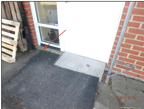
Foto 2, plåtbleck saknas, obefintlig sockelhöjd
