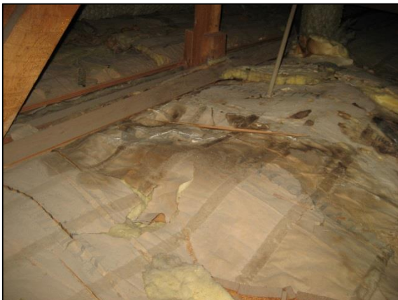
Foto 21, inläckage och fuktpåverkad mineralull
