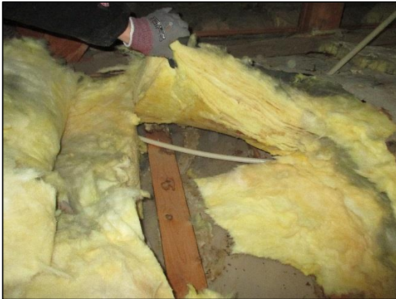
Foto 19, inläckage och fuktpåverkad mineralull
