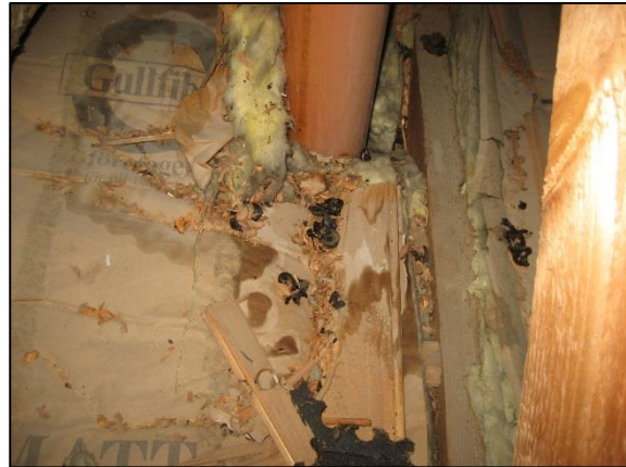
Foto 20, inläckage och fuktpåverkad mineralull
