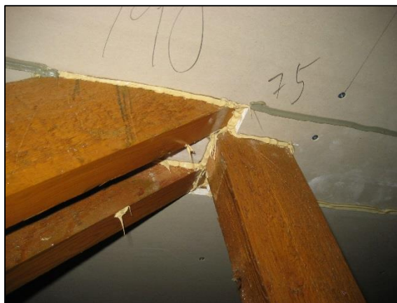
Foto 13, nya och äldre tätningar i skivskarvar
