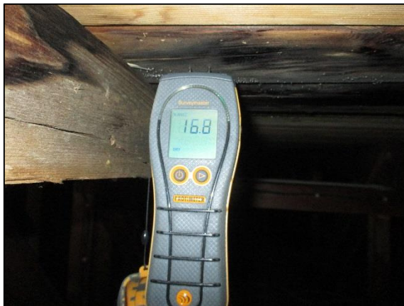
Foto 17, rötskada vid avvattningspunkt norr
