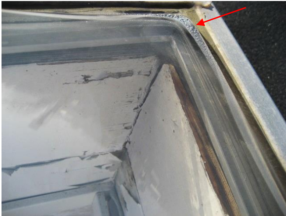
Foto 27, kondens i takkupa och fuktskador inv
