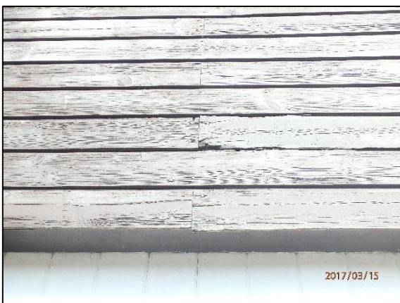
Foto 8, sprucken och rötskadad taksarg
