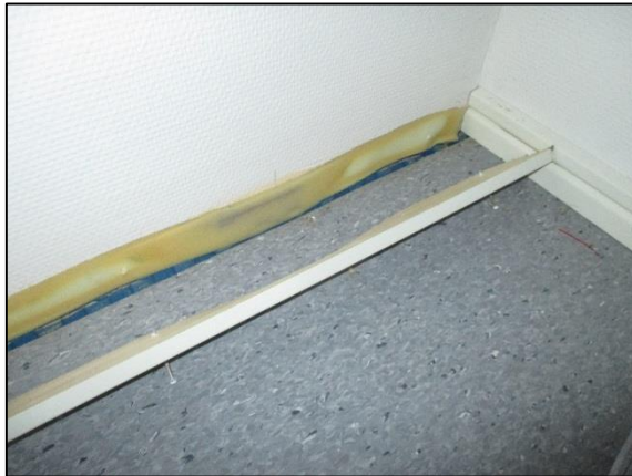
Foto 50, luftintag för ventilerat golv
