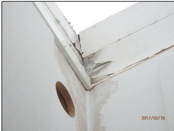
Foto 37, provpunkt 6, inläckage
