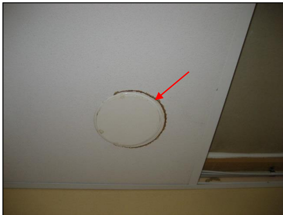
Foto 10, tecken på inläckage i akustiktak
