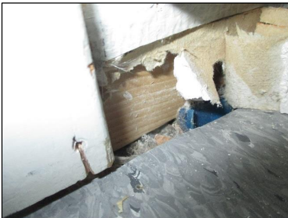
Foto 49, luftintag för ventilerat golv
