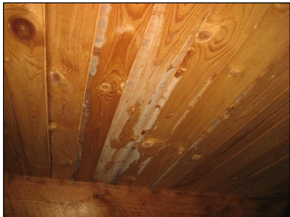
Foto 22, mikrobiell påväxt på takbrädor
