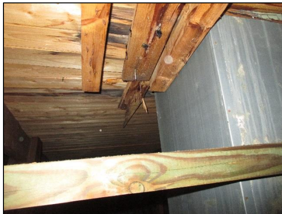
Foto 18, skador vid genomföring, impregnerat virke
