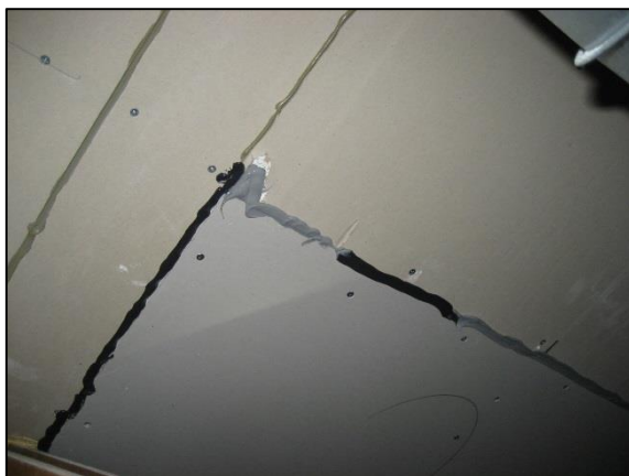
Foto 12, nya och äldre tätningar i skivskarvar
