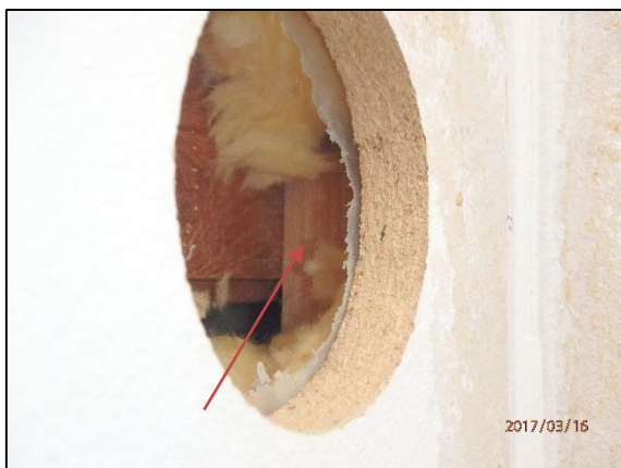
Foto 39, inga tecken på fuktpåverkan inne i sarg
