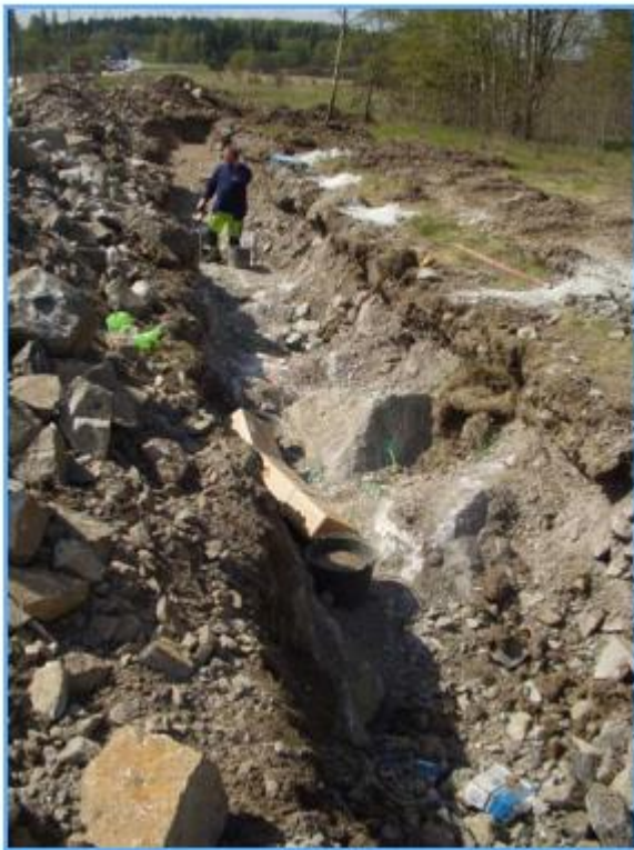
Figur 12. En kabelgrav innebär omfattande schaktarbeten, ofta också sprängning längs sträckan.
