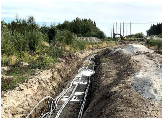
Figur 4. Foto över markförläggning av kabel. (Foto: Erik Spinnel).
