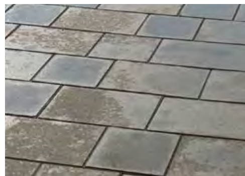
Betongplattor med genomgående fogar
