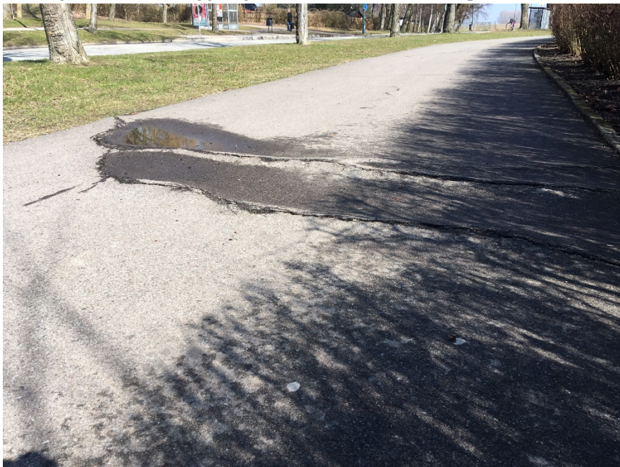
Bild 12: Malörtsvägen - rötter lyfter asfalten på den kombinerade gång- och cykelbanan.
