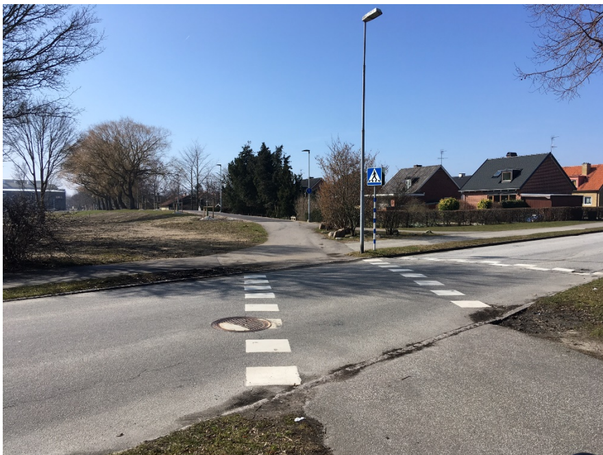
Bild 6: Korsningspunkt vid Tallvägen. Ojämn beläggning söder om korsningspunkten samt precis där gång- och cykel
