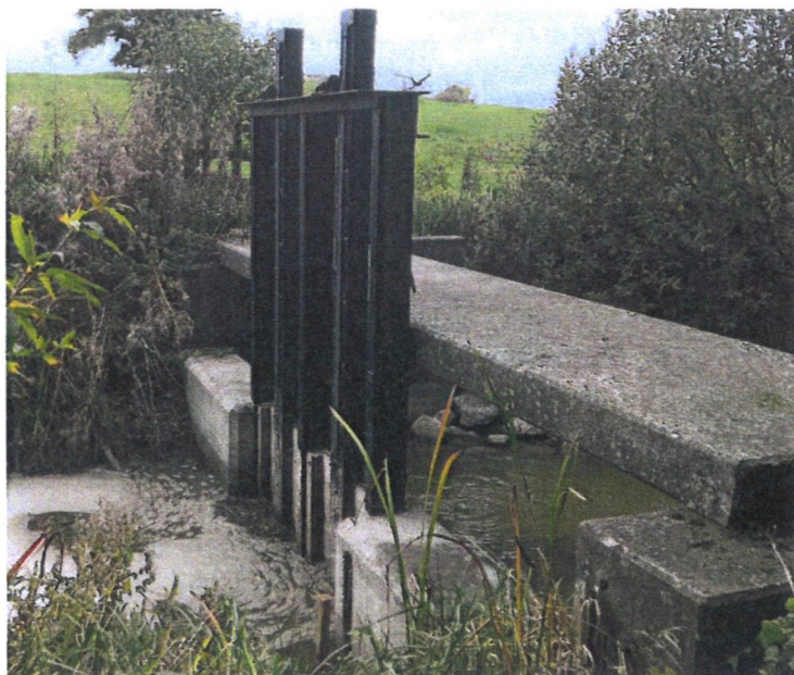
Figur 6. Börringesjöns utloppsdämme. Kan bli bättre både med avseende på fördröjning och passerbarhet för fisk. Foto: Filip Hvitlock.
