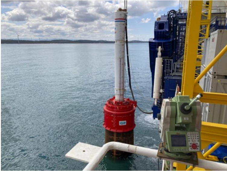
Figur 1:Hydraulisk hammare. (Källa: IQIP)
