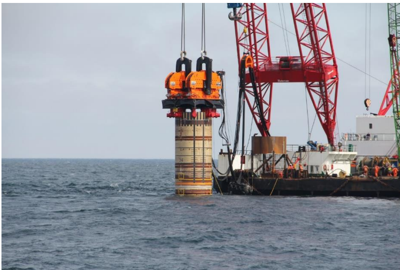
Figur 3: Vibrationspålning. (Källa: TU- Delft)
