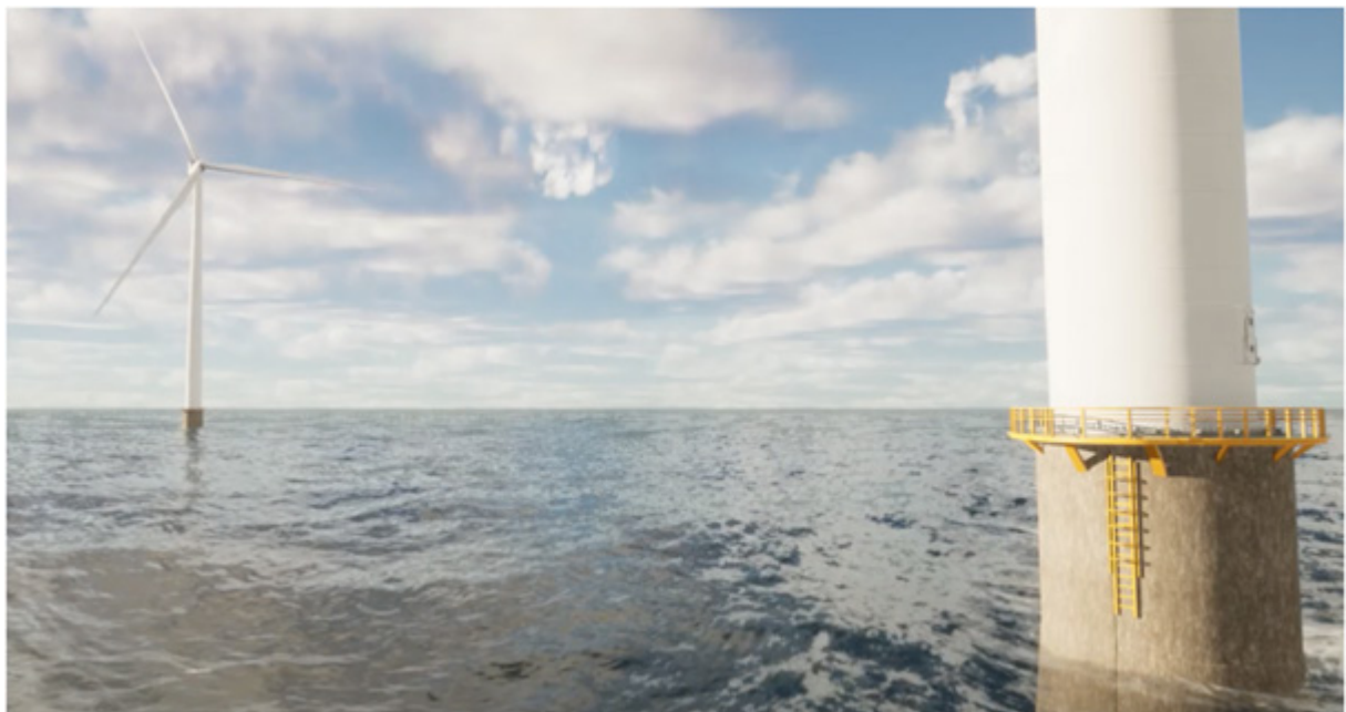
Figur 3 Installerat bergsförankrat fundament.
