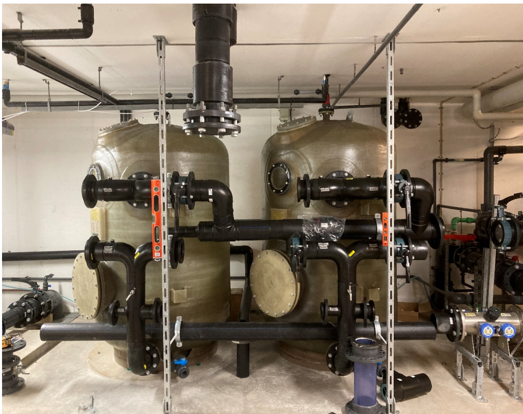
De nya sandfiltren till rehab bassängen.
